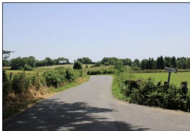
Route communale au Sud du projet
